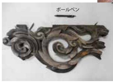
落下した懸魚の「ひれ」
