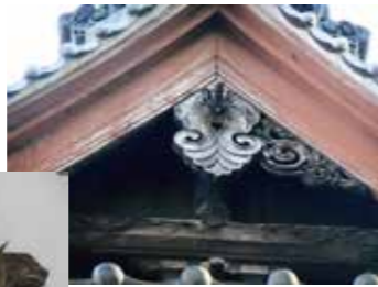
拜殿の屋根を見上げると、懸魚の左側のひれが落下している。現在は復元している。
