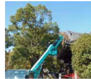
高所作業車で枝落しが行われた。
